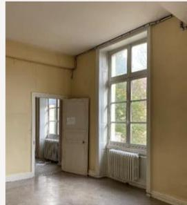
L'ensemble des menuiseries est prévu remplacé pour des raisons d'état sanitaire, mais également pour améliorer leurs capacités thermiques. Bois structurel, grands carreaux, double vitrage.
